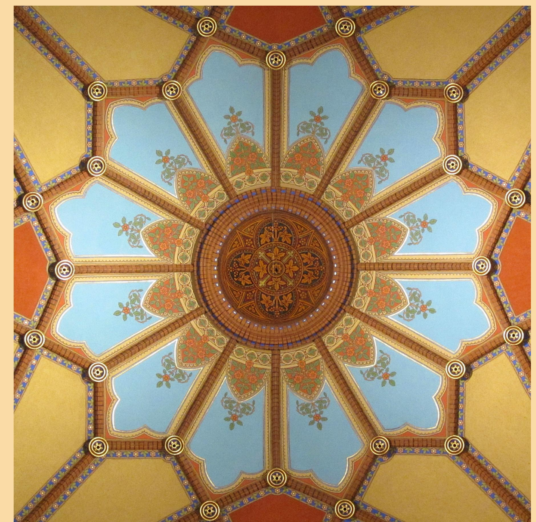
Nach vielen Wochen schwerer Arbeit über Kopf erstrahlt die Hauptkuppel wieder in neuem Glanz.
