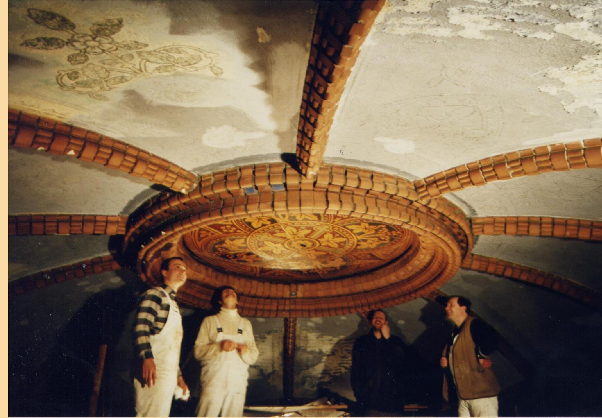
Die Hauptkuppel wird untersucht.
